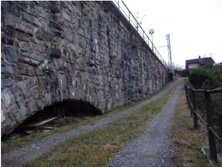
Zufahrt Alte Sust
