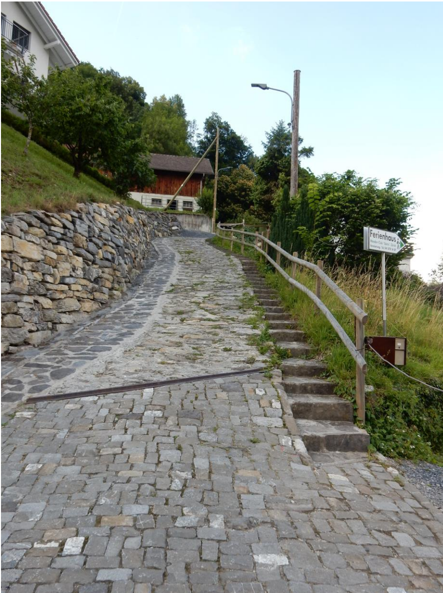
Bauen: gepflasterter Zufahrtsweg und Trockenmauer
